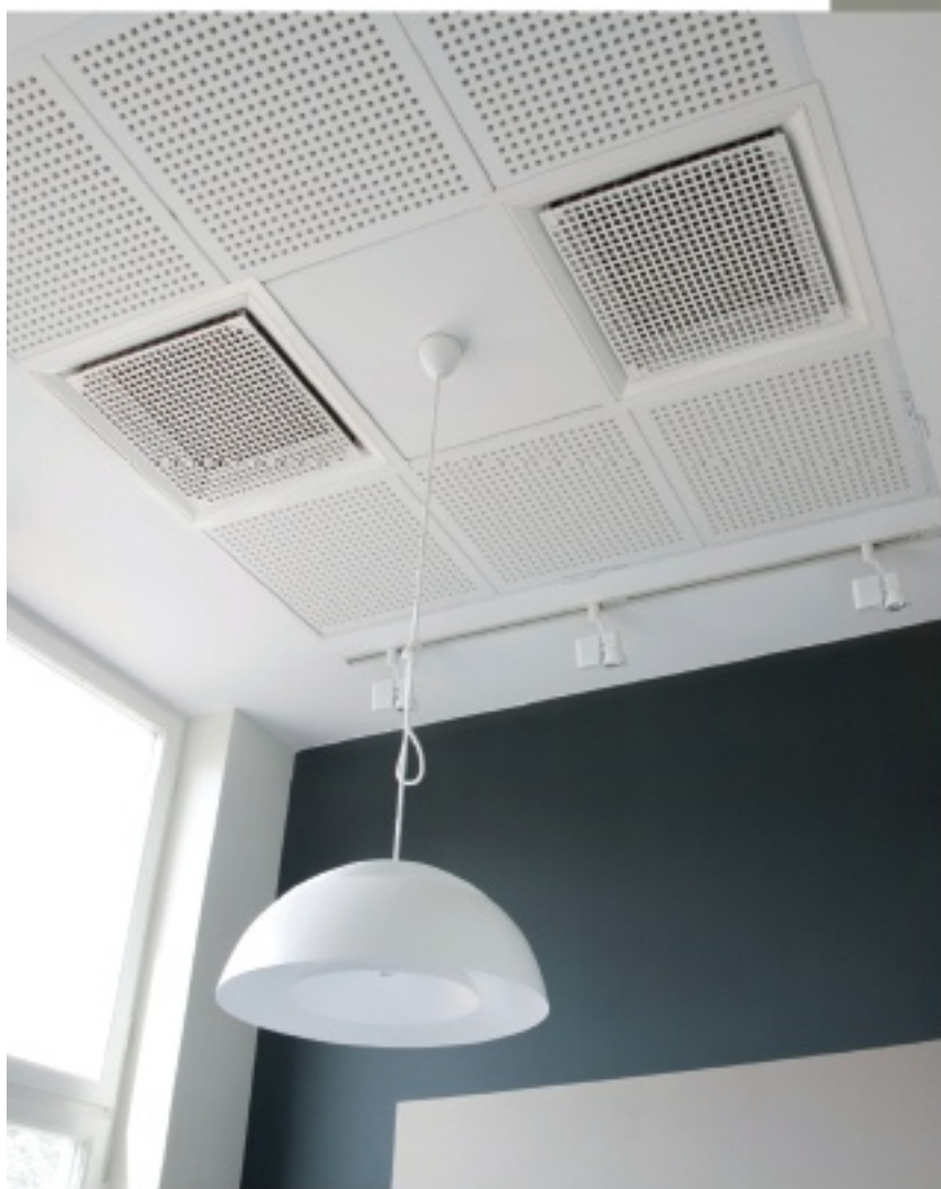
Przykładowe rozwiązania dwóch rodzajów sufitowych modułów chłodząco-grzewczych
